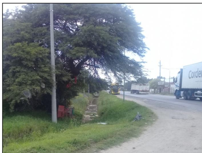
Fig. 12 – Fotografía de Zanja sin Salida de Barrio Pinar de las Tejas y Terraplén de Ruta 2
